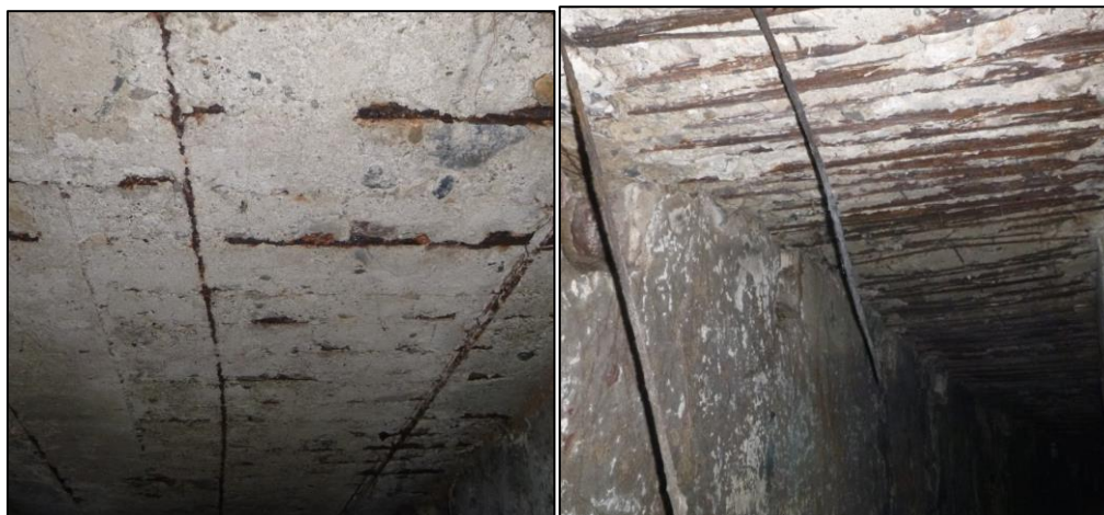
Figura 25 – Esempio di ammaloramenti sui lati interni del canale
