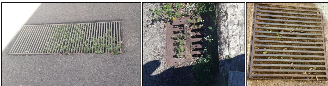
Figura 26 – Esempio di caditoie ostruite
