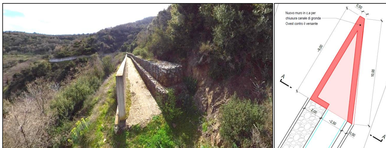
Figura 8 – Imboccatura di monte canale di gronda ovest (stato di fatto e intervento di progetto)
