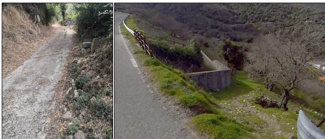
Figura 10 – Strade canale con segni di erosione ai piedi del versante
