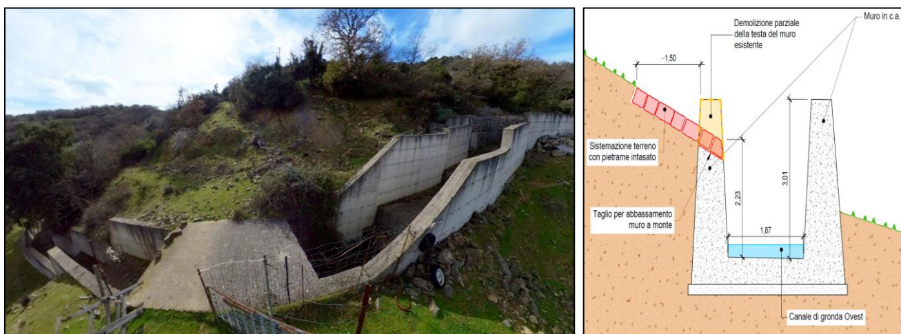
Figura 7 – Canale di gronda ovest con muri di sponda lato versante più alti del versante
